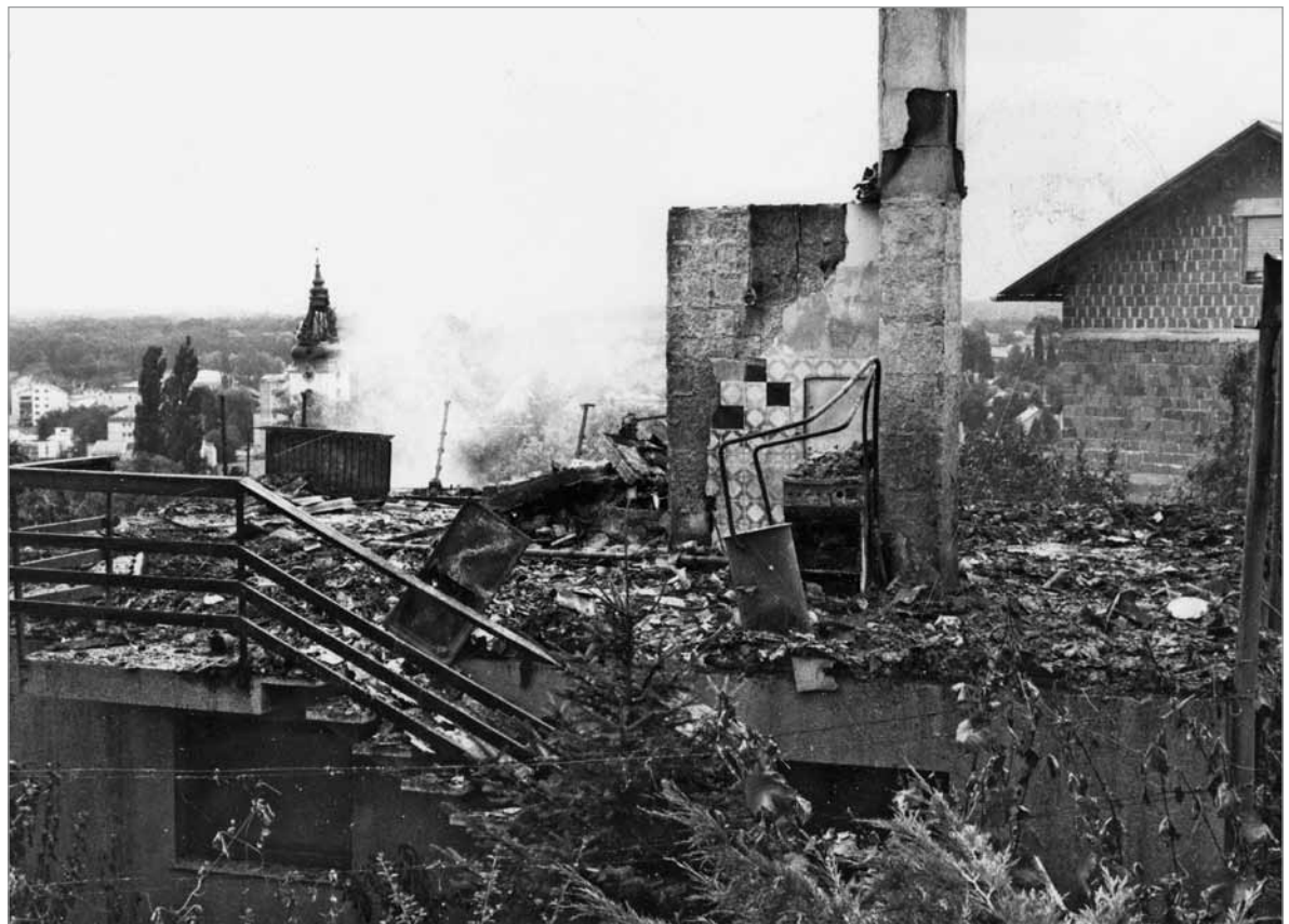
Uničena stanovanjska hiša in poškodovan zvonik cerkve sv. Petra v Gornji Radgoni. Foto: Nataša Juhnov, Vestnik
